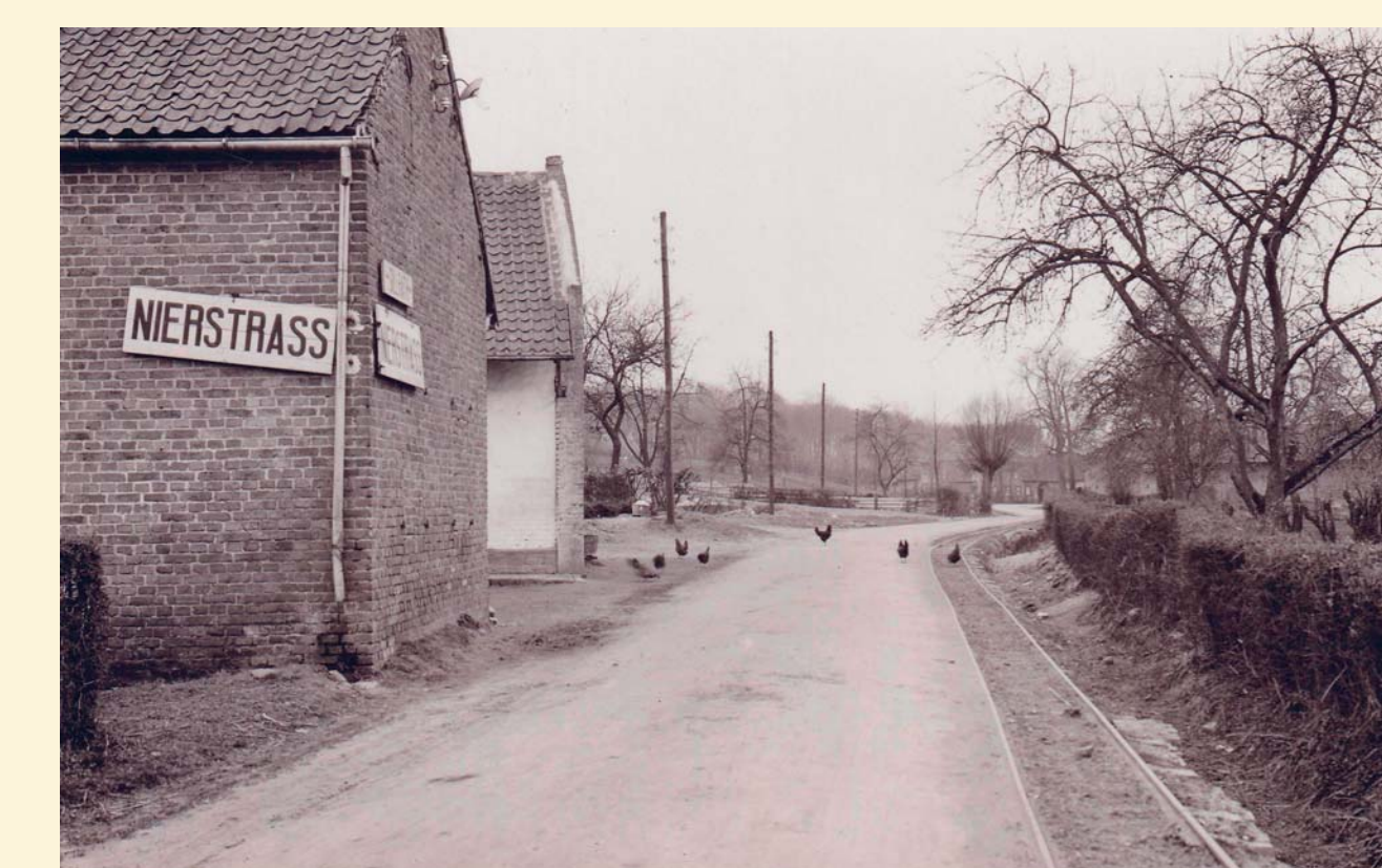
Schienen der Feldbahn durch Nierstraß an der ehemaligen Gaststätte Deußen
