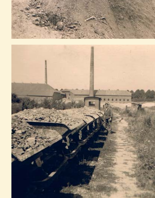
Später erleichterten Maschinen wie der Grubenbagger die Tongewinnung und der Transport wurde mit Feldbahnen und Kipploren vorgenommen.
