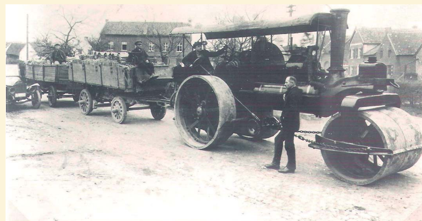
1920: Abtransport der Dachziegel bei van Daal in Panneschopp mit einer Dampfwalze. Bevor der schwere Transport den Bahnhof in Geilenkirchen erreichte, musste die Wurmbrücke zwischen Geilenkirchen und Hünshoven für die Überfahrt gestützt werden.
