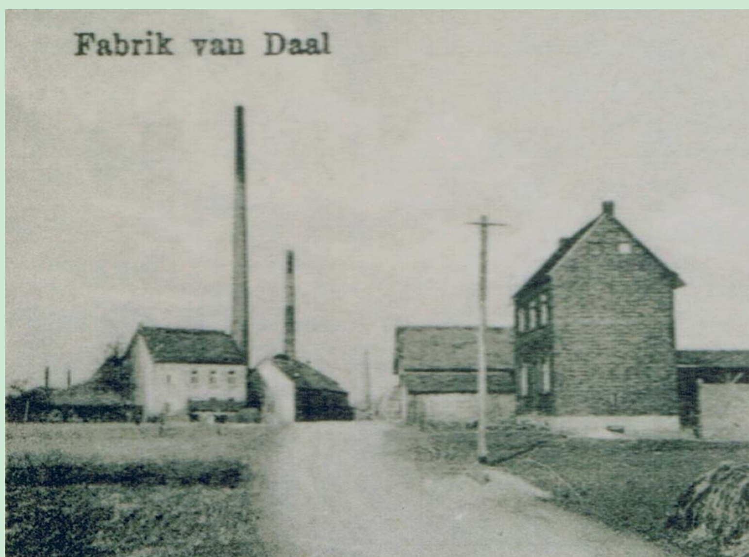
Das Falzziegelwerk Van Daal von Nierstraß aus gesehen
