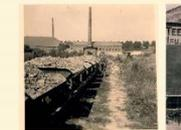
Mittels einer Feldbahn wurde der benötigte Ton aus den Tongruben in Panneschopp und Bockst geholt.
