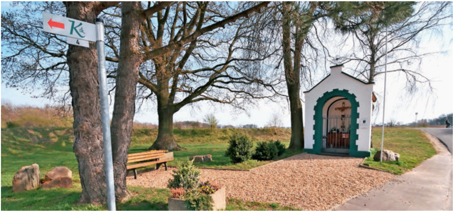
Die hübsche Kapelle Gillrather Hof (Station 3) hat ihren Standort an einem der ältesten Gutshöfe in der Umgebung. Sie wurde 1890 errichtet – ein kleiner Backsteinbau unter einem Satteldach.
