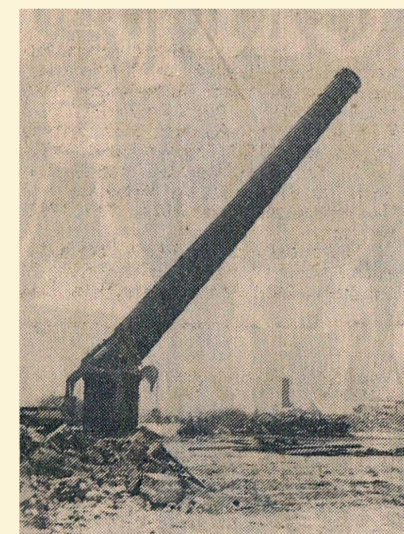
Der Kamin der Fabrik fiel am 19. Dezember 1981
