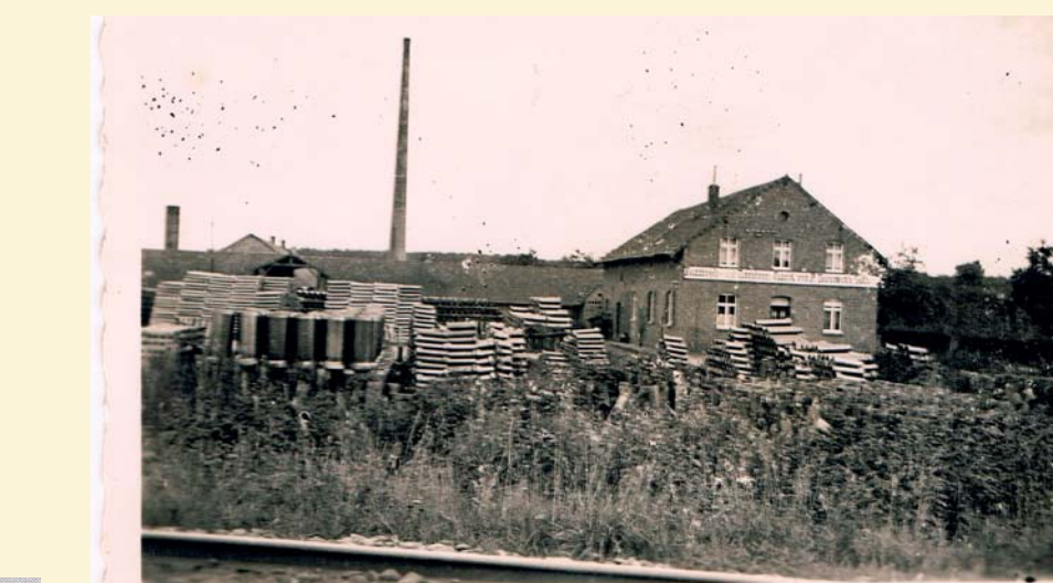
Das alte Bürogebäude der Fabrik
