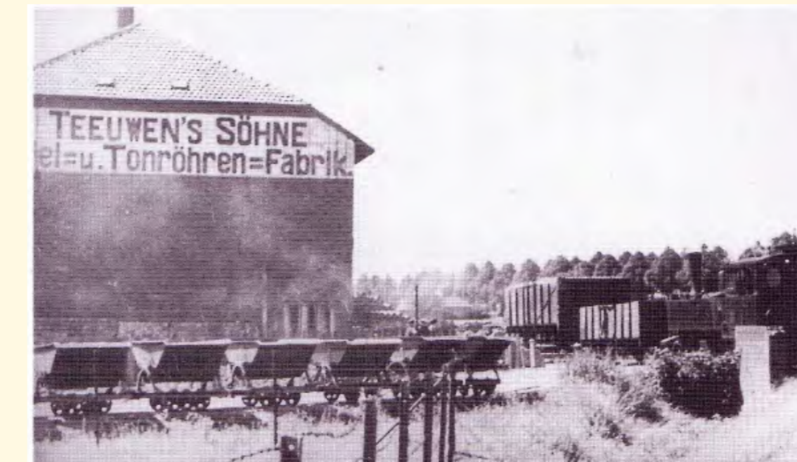
Nebengleis mit Güterzug an der Ziegelei Paul Teeuwen's Söhne (das Gebäude ist heute noch erhalten). Im Vordergrund die Feldbahn der Ziegelei, die Ton aus Panneschopp anliefert.
