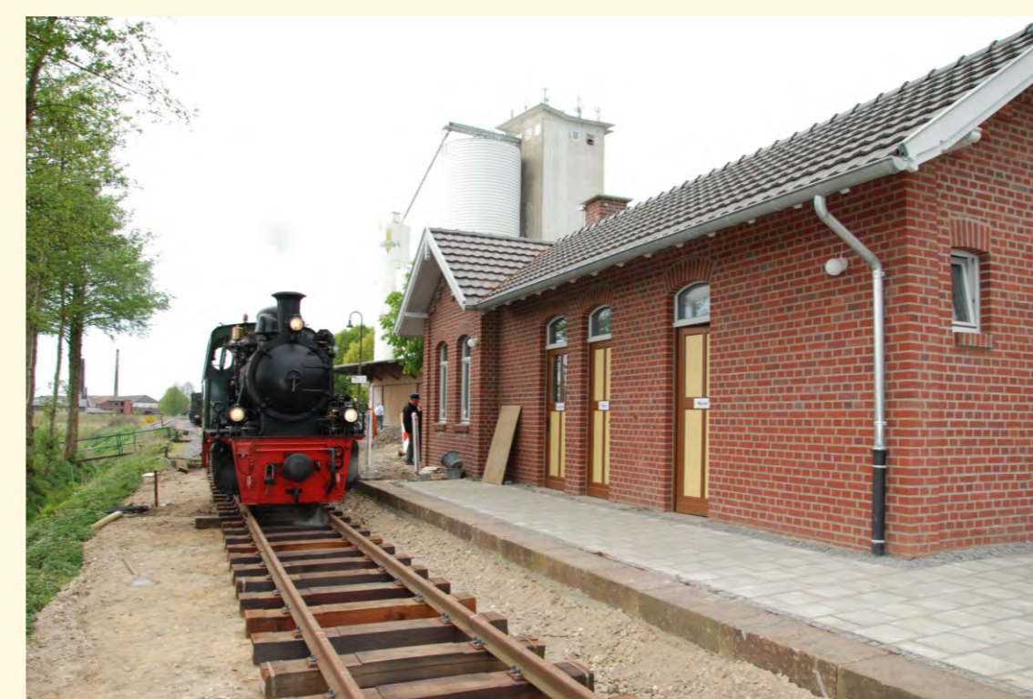
Seit 2014 hat der Bahnhof Gillrath wieder ein Stationsgebäude, das von der IHS errichtet wurde.
