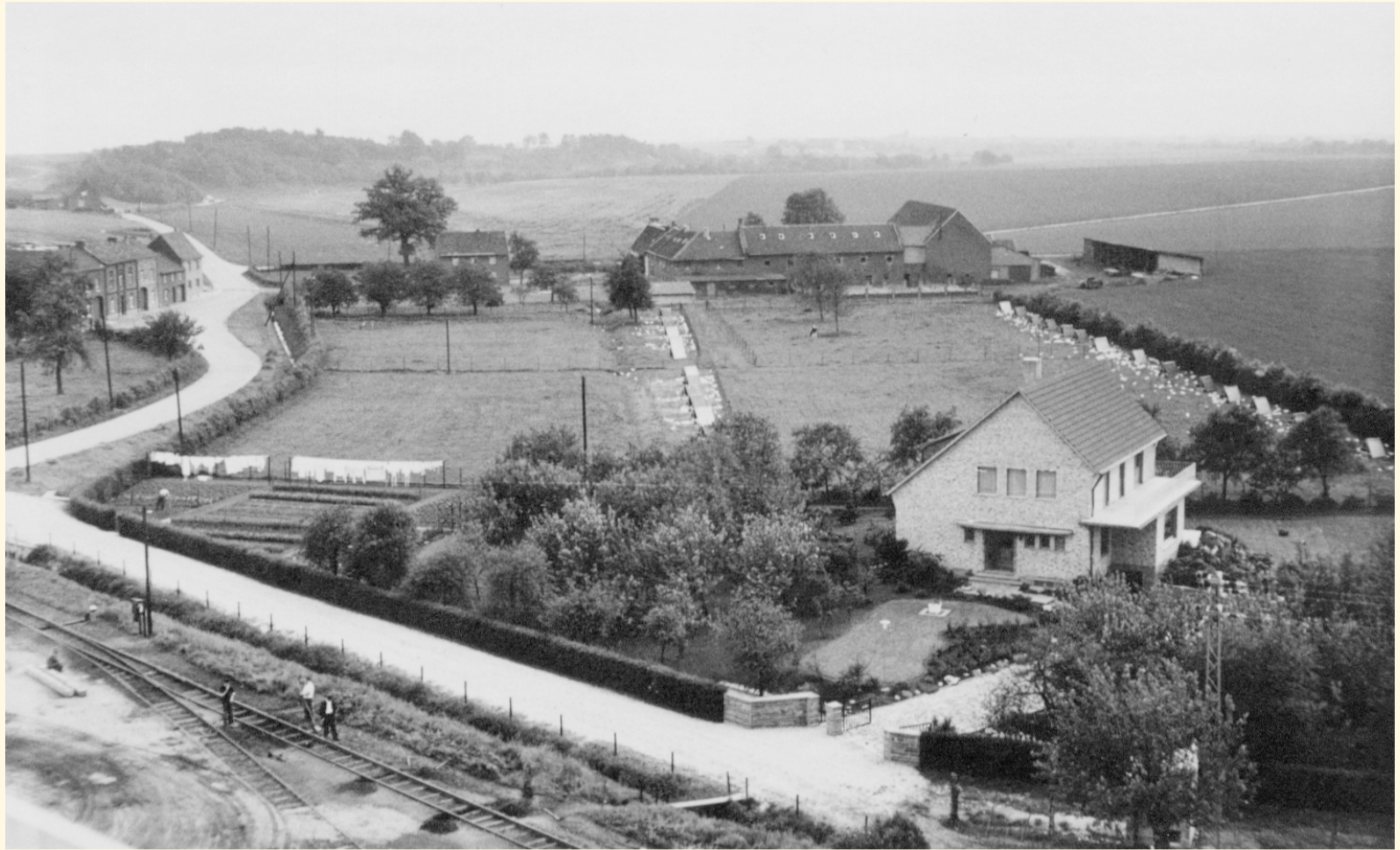
Die Bergstraße 1959 vor der Begradigung und Bau der Kanalisation. Im Hintergrund der Gillrather Hof mit dem Schweizer Haus, das nach 1970 abgerissen wurde.
