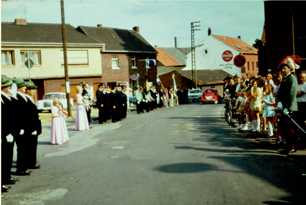
Der Umgehungstraße mussten die Häuser von Paul Verbong, der ein Friseurgeschäft betrieb, weichen (auf dem Bild die beiden linken Häuser). Auch das alte Haus von Josef Kohnen, das gegenüber dem Pastorat lag, musste wegen des Ausbaus der Straße abgerissen werden
