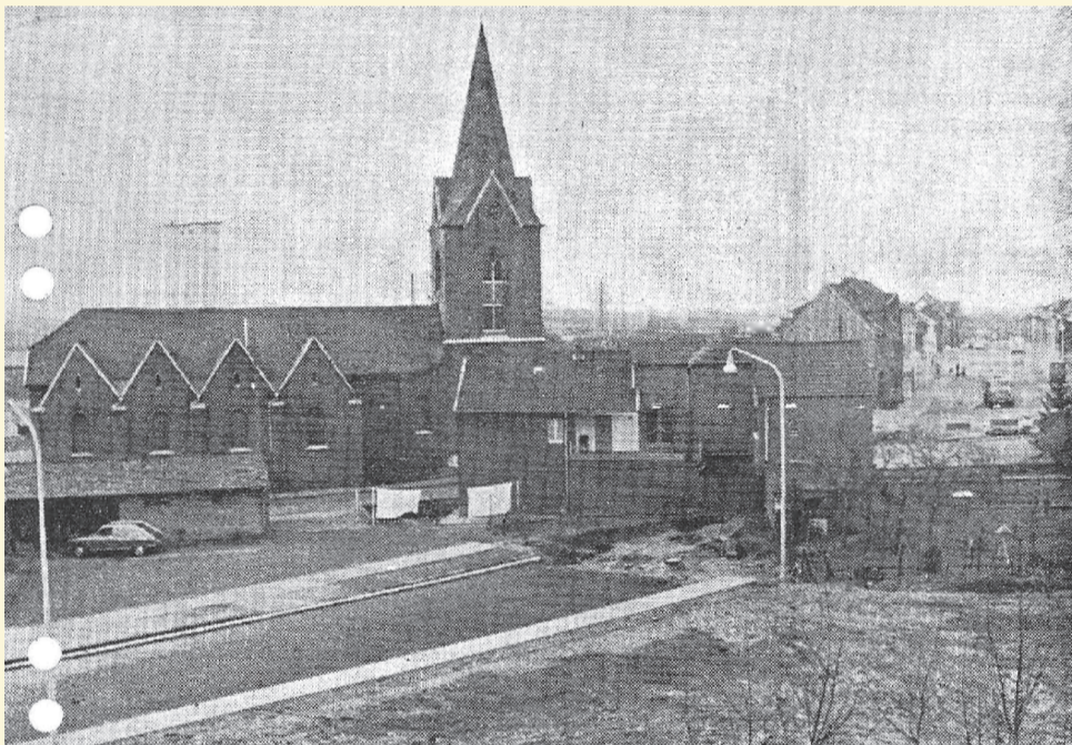
Die neue Straße konnte erst 1974 fertiggestellt werden, da sich ein Eigentümer weigerte, sein Haus abreißen zu lassen.
